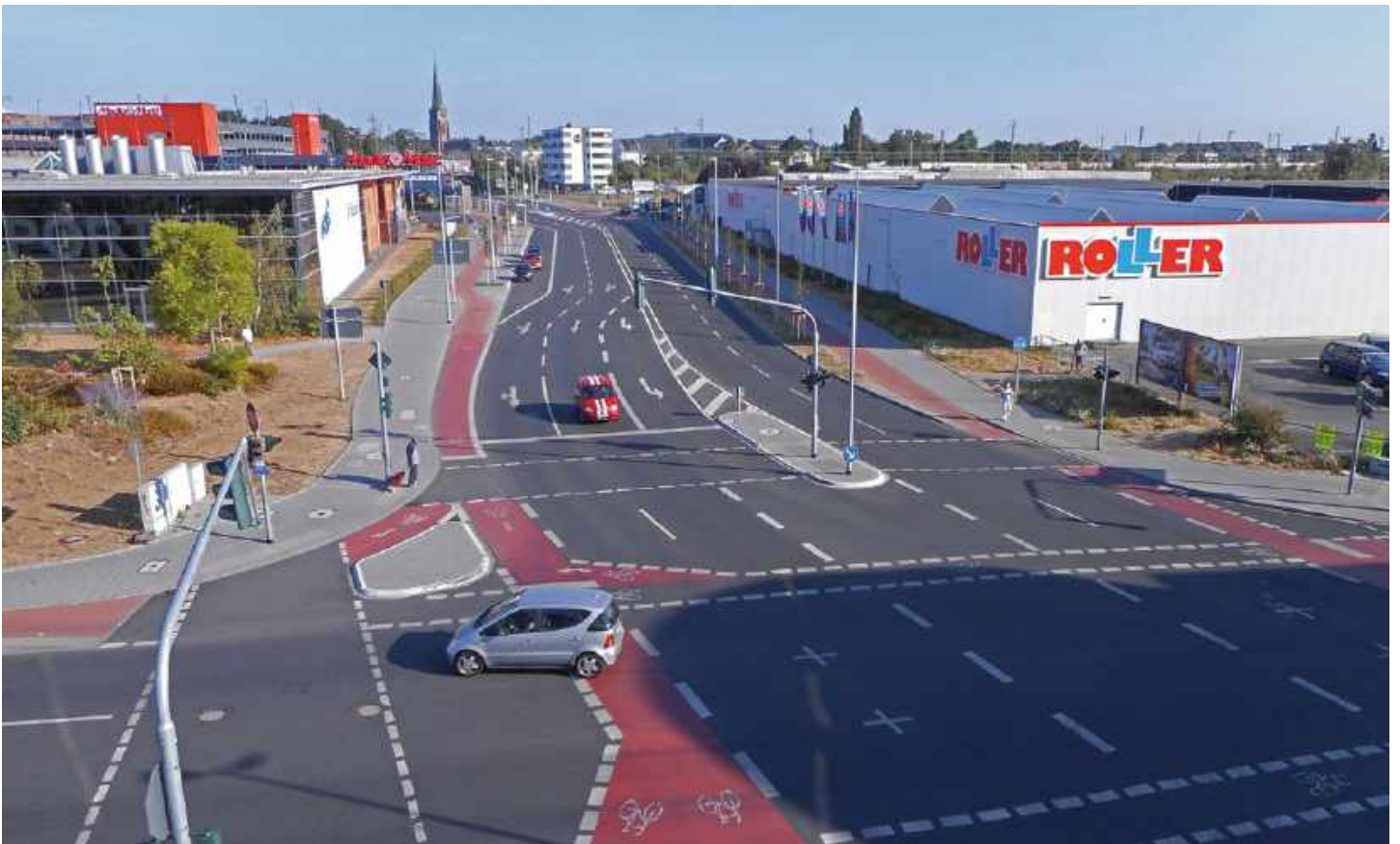
Baumaßnahmen Mönchengladbach, Breitenbachstraße
